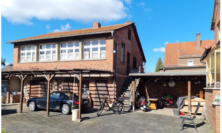
Blick auf das Wohngebäude Bahnhofstraße / Ecke Vogelsbergstraße mit ehem. Diamantschleiferei.
